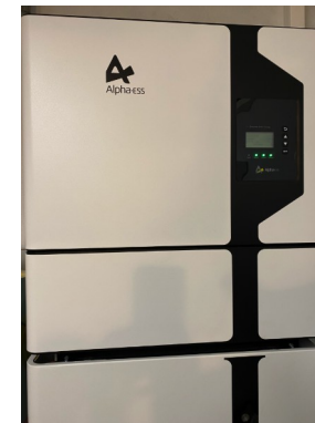
Bilder 3 und 4: Inverter, darunter Batterie
