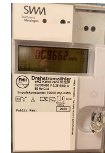
Bild 6: Zähler; Einspeisung (280)
