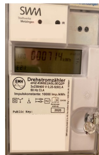
Bild 5: Zähler; Netzbezug (180)
