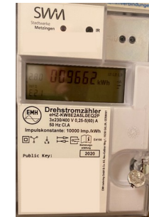
Bild 6: Zähler; Einspeisung (280)
