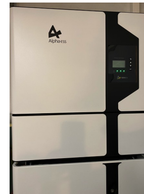
Bilder 3 und 4: Inverter, darunter Batterie
