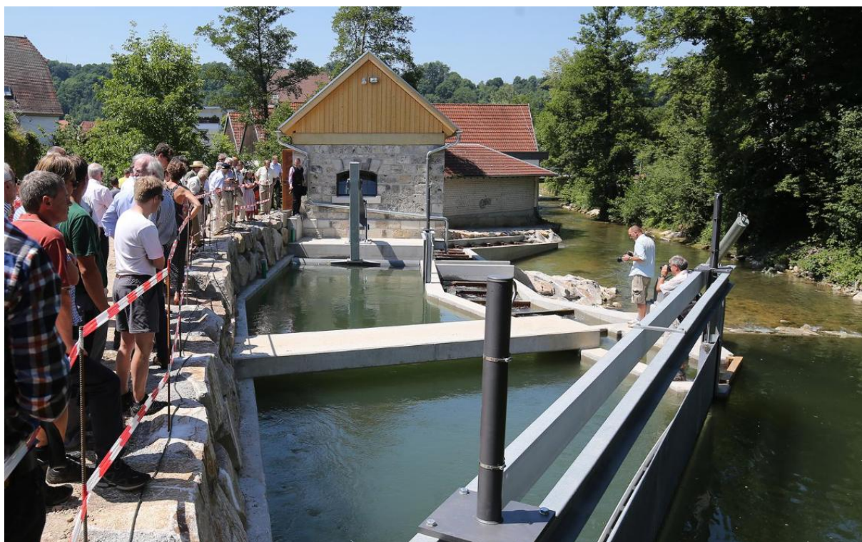
Quelle. Südwest-Presse: Laufwasserkraftwerk an der Erms in Bad Urach, installierte Leistung 25kWh
