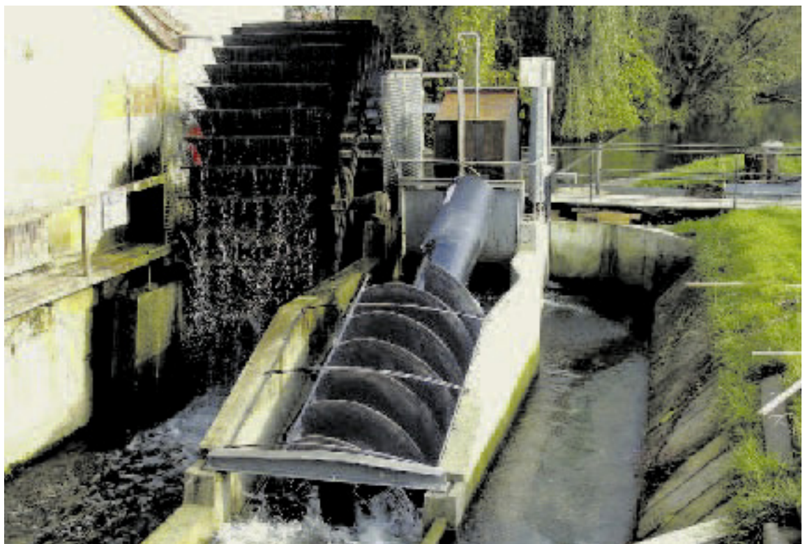
Wasserrad und Wasserschnecke an einem Mühlkanal Bild: Fa. Ritz- Atró, Pumpwerksbau, Nürnberg
